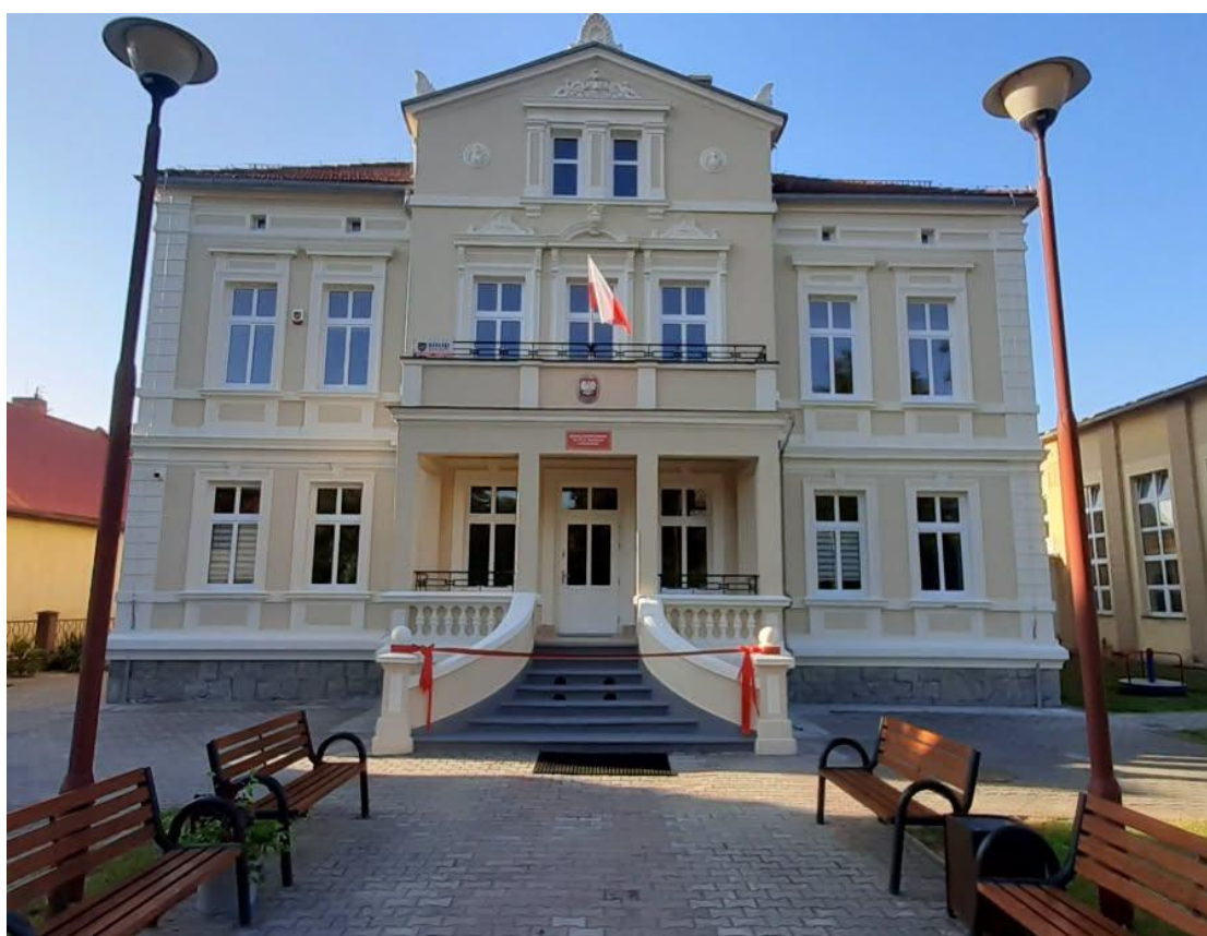
Budynek szkoły podstawowej w Rosochatej, dawniej „Villa Matzke”.
